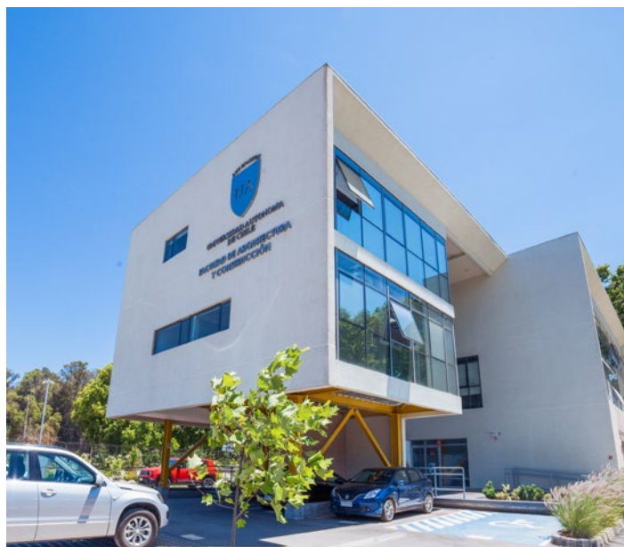
Edificio Ing. en Construcción, Sede Talca
