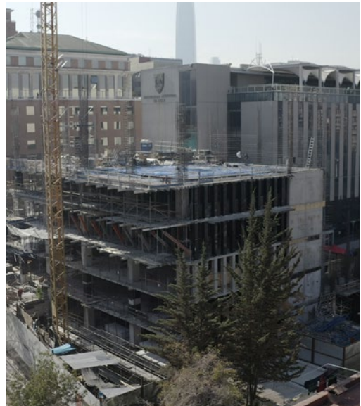
Ejecución obra Campus Providencia, edificio C
