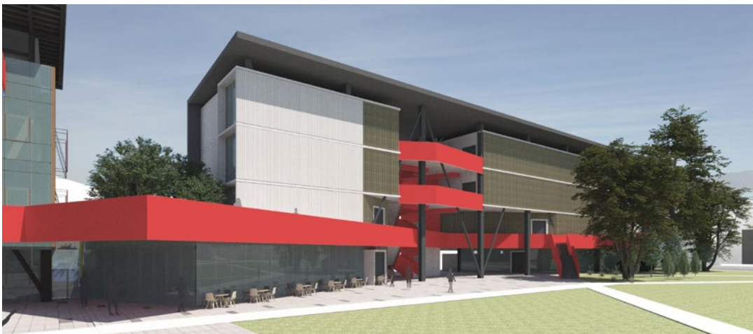
Edificio H, vista del suroriente
