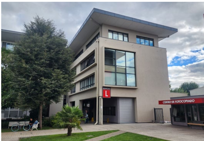
Ampliación Ed. L, Sede Temuco
