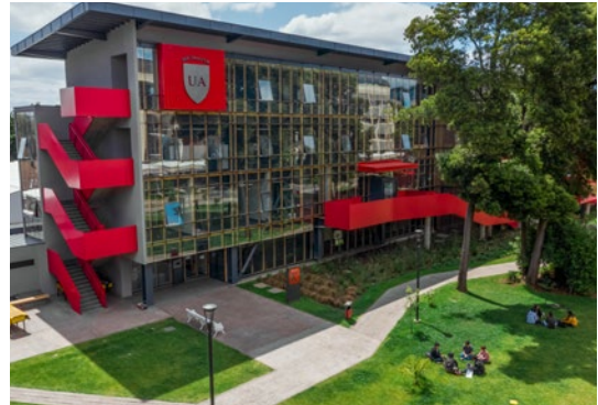
Edificio K, Sede Temuco
